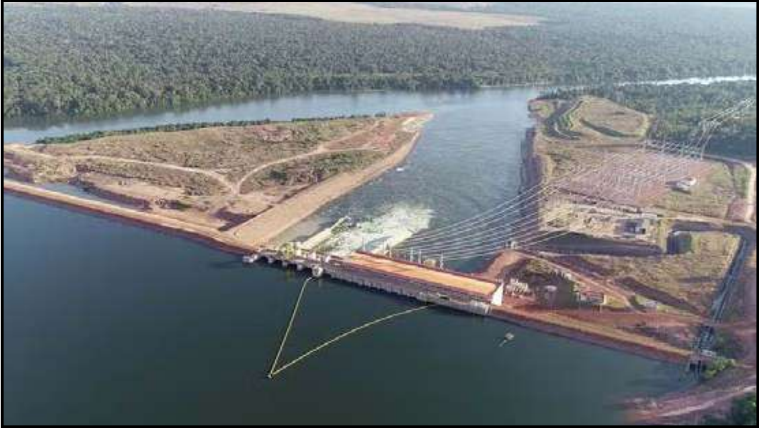
Falhas podem levar a uma ruptura da barragem
