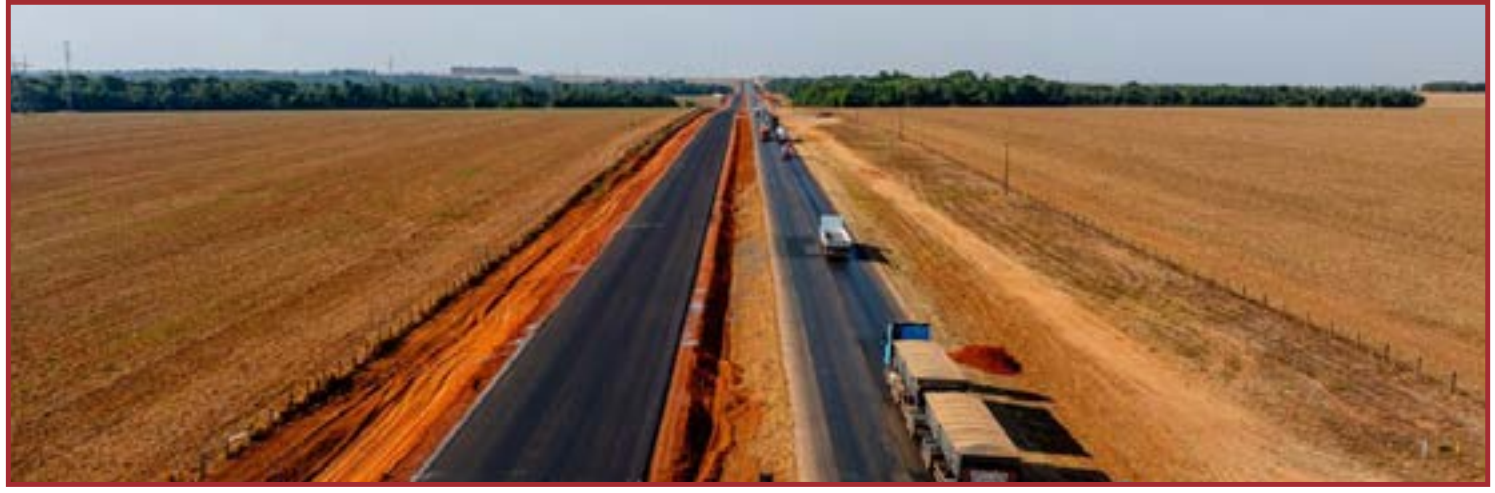
Expedição 163 entrega 130 km de novo pavimento na rodovia federal
