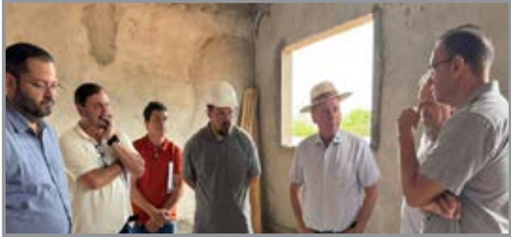
Prefeito vistoria trabalhos
