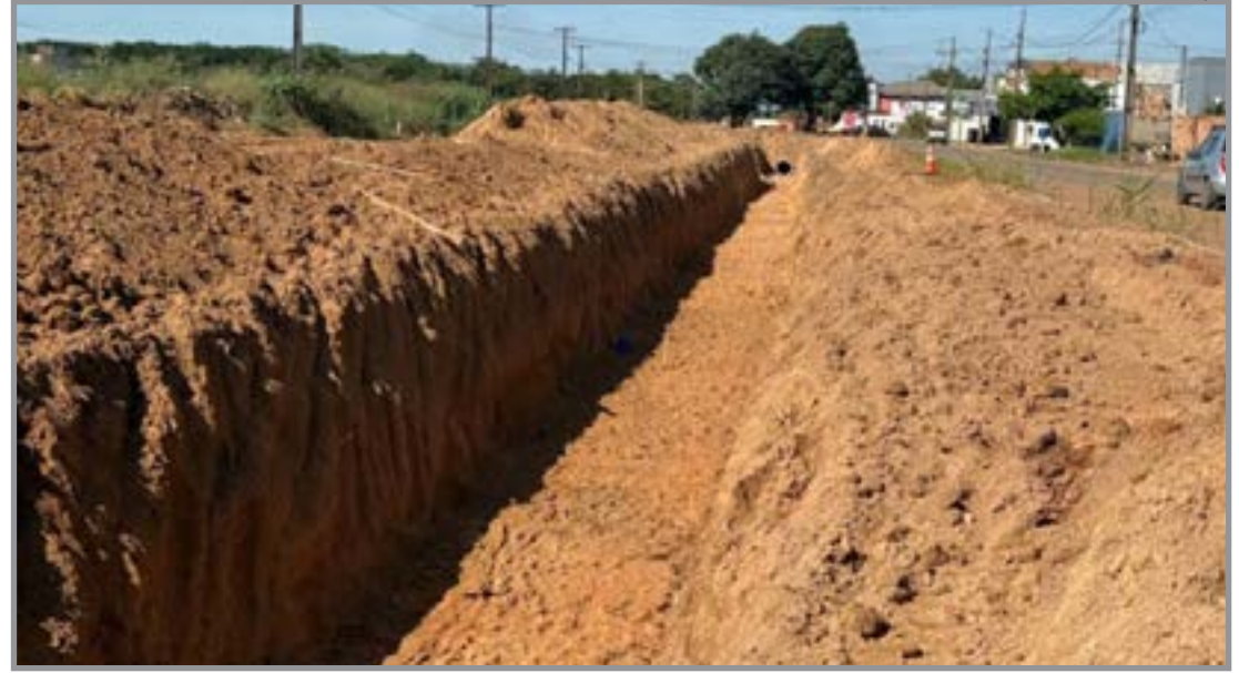
Obras em diversos pontos da região centro-sul da cidade
