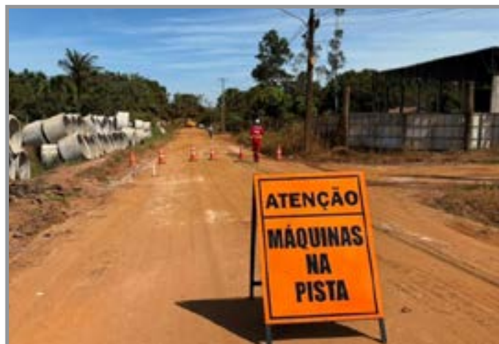
Asfaltamento em 13 pontos da cidade
