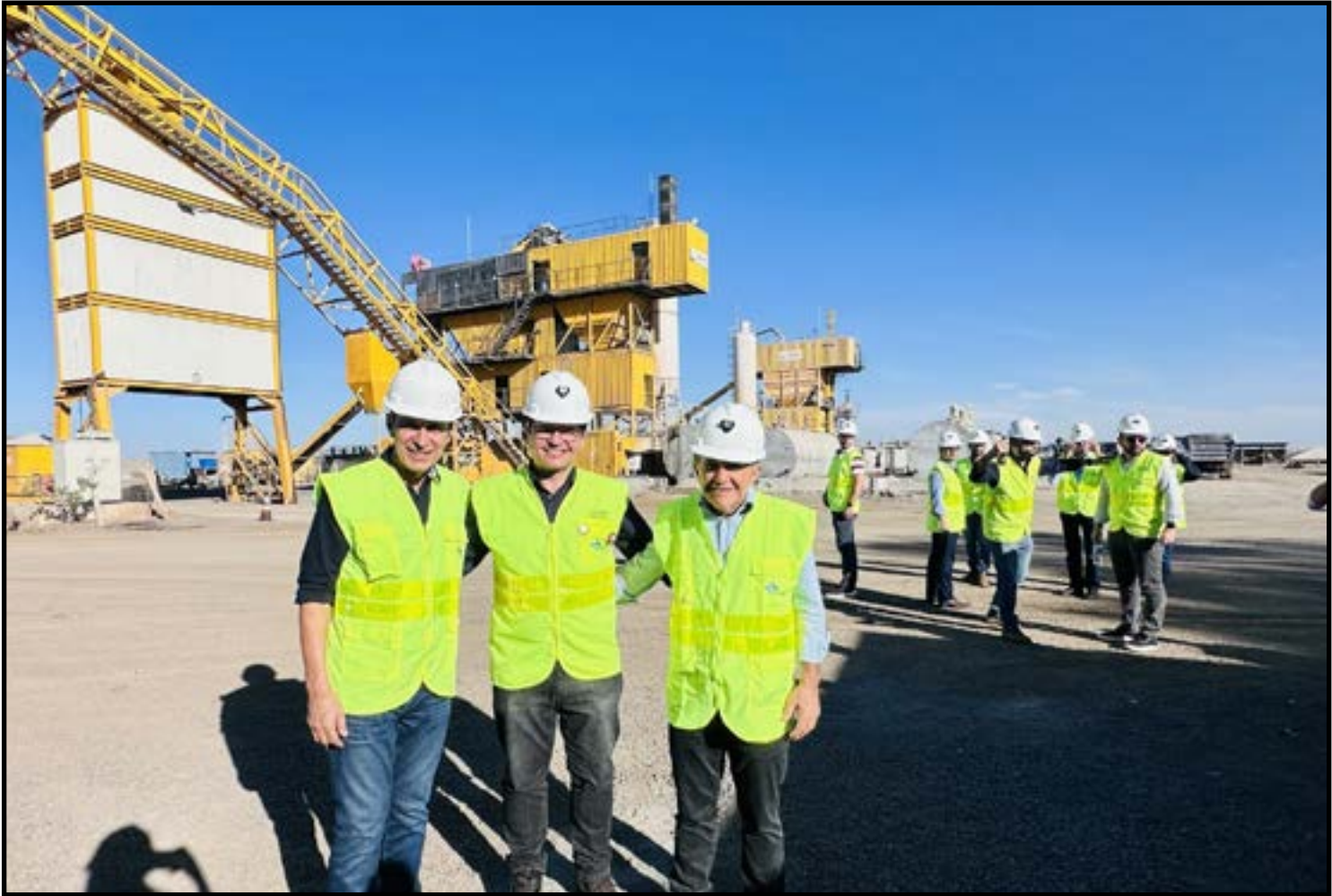
Vaz e Piccini participaram da vistoria técnica das obras
