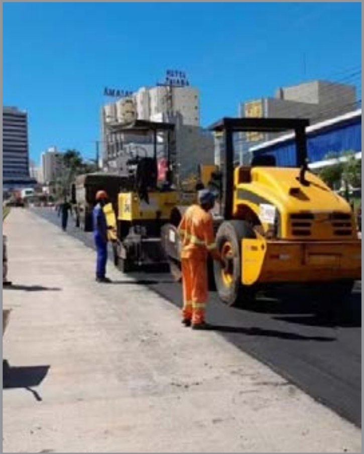
Governo ampliou novamente o prazo de execução das obras
