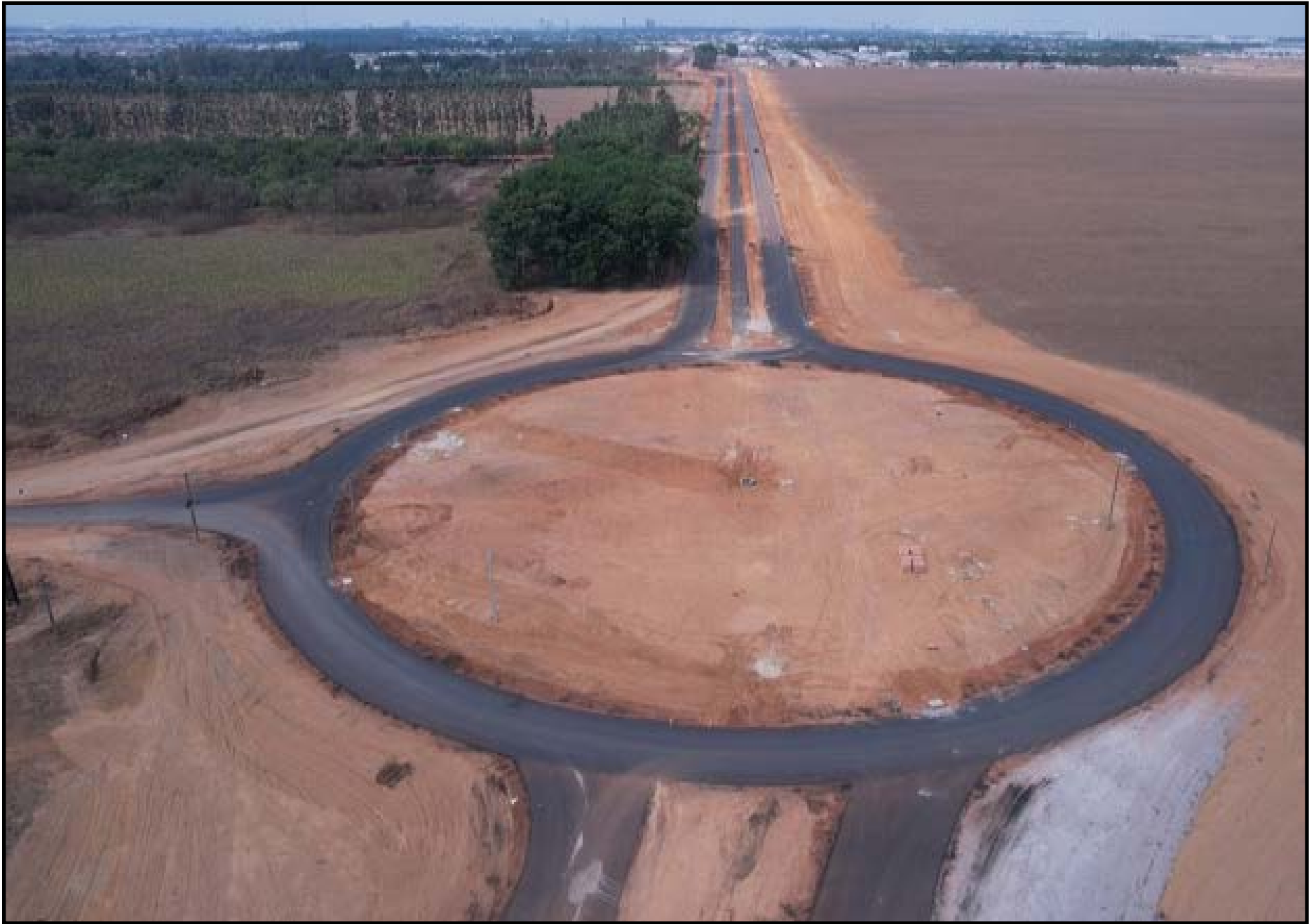
Intervenção segue com serviços de drenagem em toda a extensão da nova ligação viária
